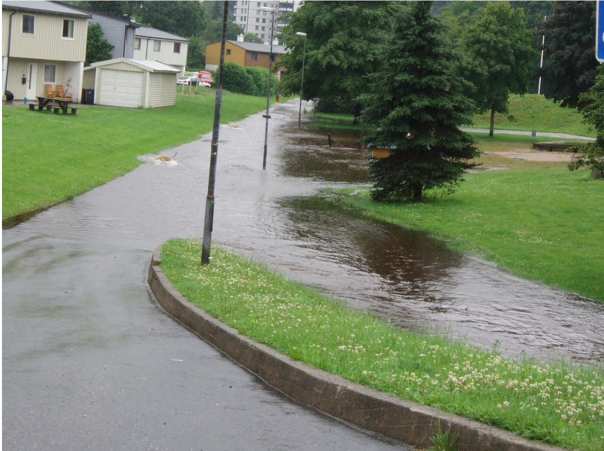
Figur 1. Mølle vannskanalen som flomveg.
