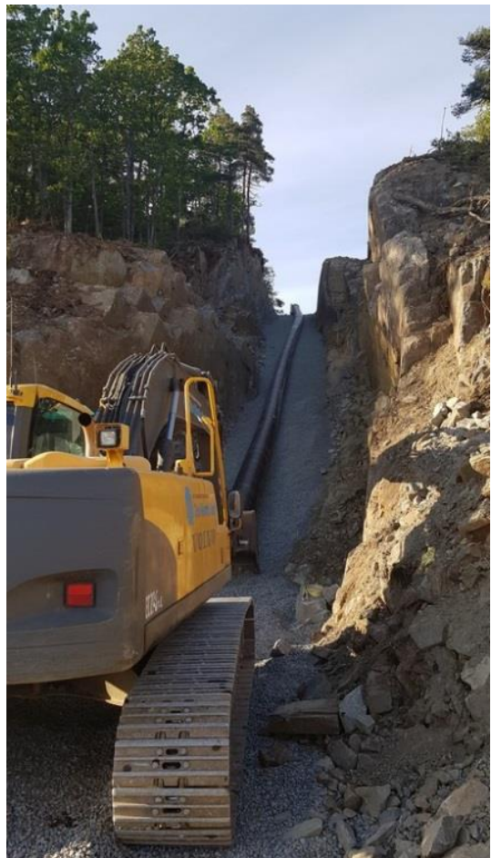
Figur 67 Vannledning 800 mm til nytt basseng på Grasåsen, del av reservevannledningen.
