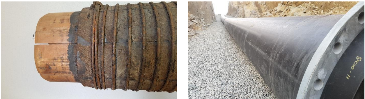
Figur 1 Treerør fra 1800-tallet i Kvadraturen, og 800 mm PE-rør fra 2017 ved Grasåsen.
