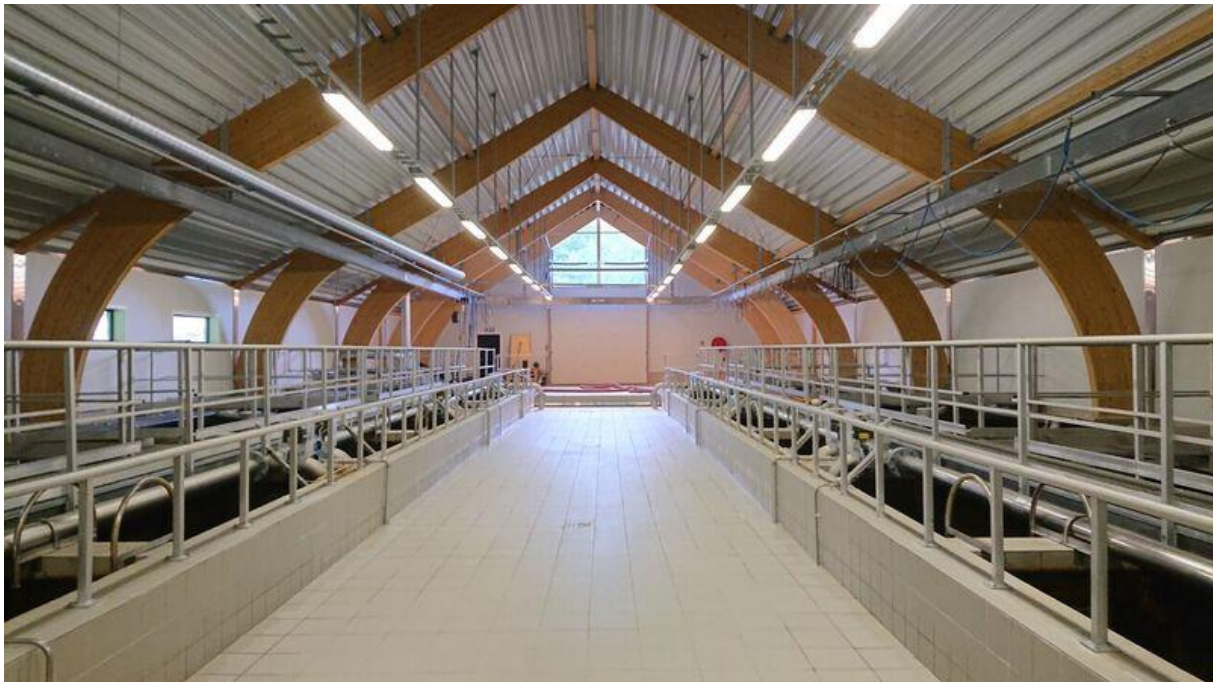
Figur 12 Tronstadvann vannbehandlingsanlegg, filterhall.
