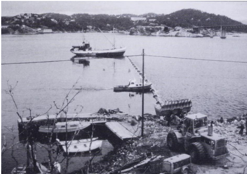
Figur 5 Vannledning over Topdalsfjorden før senkning i 1977. (Holte, 1992)
