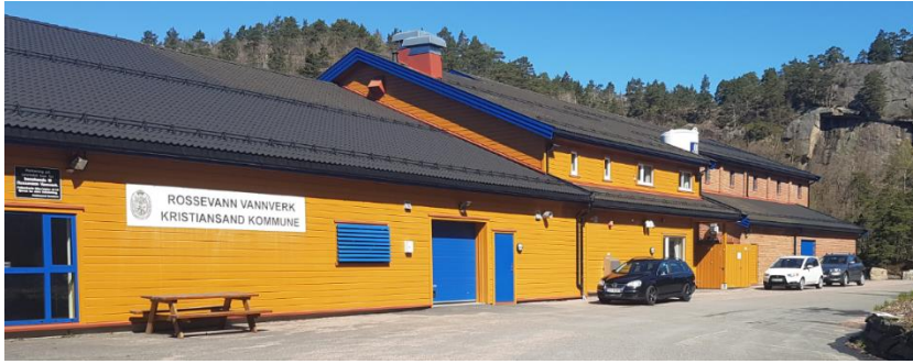
Figur 7 Rossevann vannbehandlingsanlegg, mai 2017.
