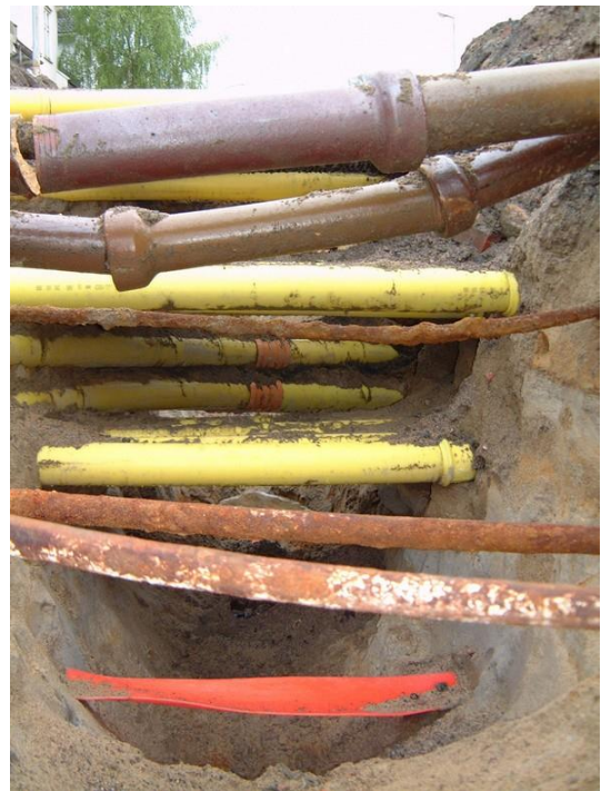
Figur 69 Hva som er i bakken – graving i Tordenskjoldsgate.
