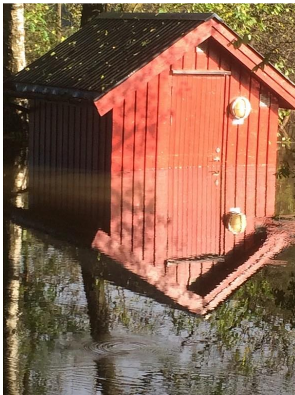
Figur 70 Kallebrotet pumpestasjon i oktober 2017.
