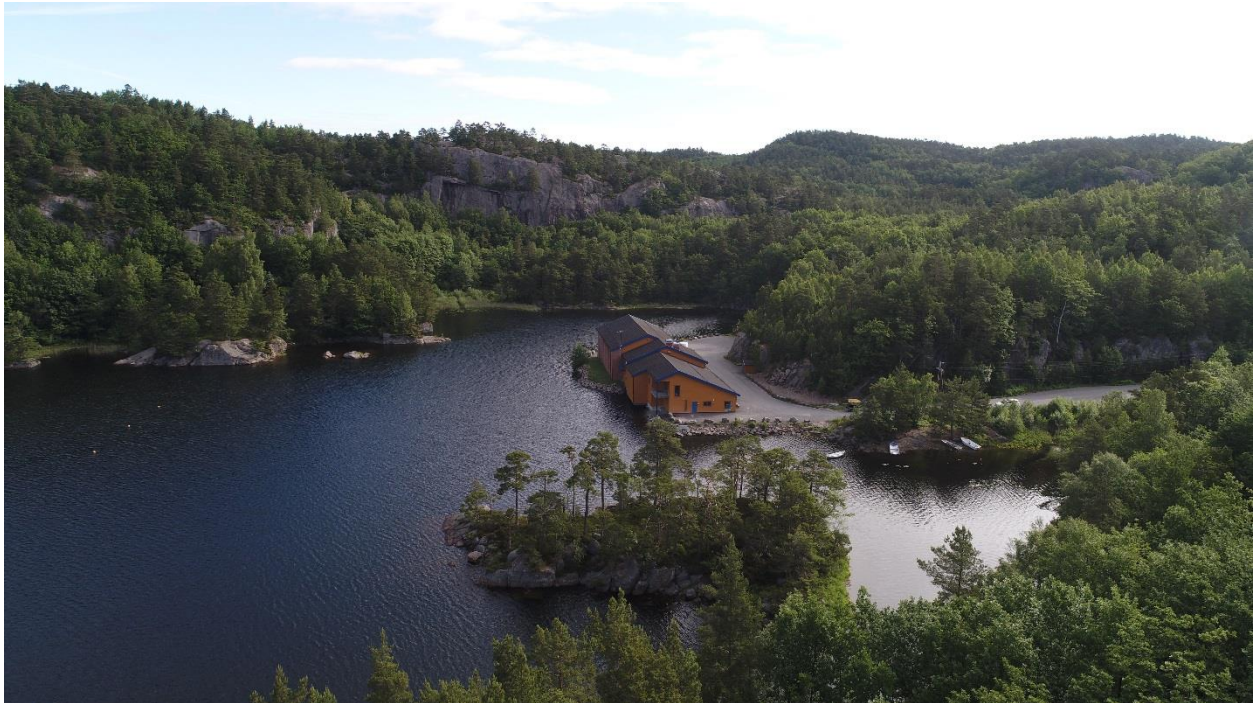
Figur 11 Rosse vann vannbehandlingsanlegg. Dagens inntakspunkt i venstre del av bildet.
