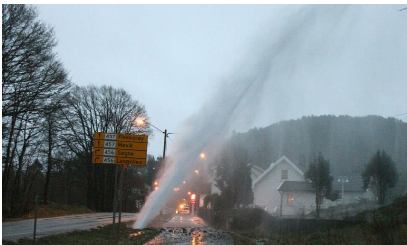
Figur 66 Lekkasje i Kjosbukta (Fædrelandsvennen).
