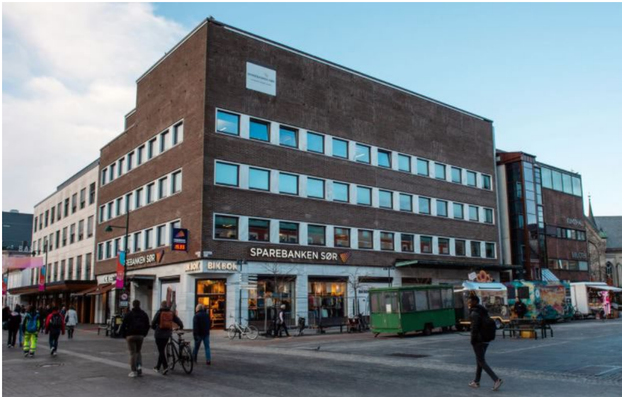
Figur 4: Bilde, Sparebanken Sør, kryss Markens gate - Rådhusgata
