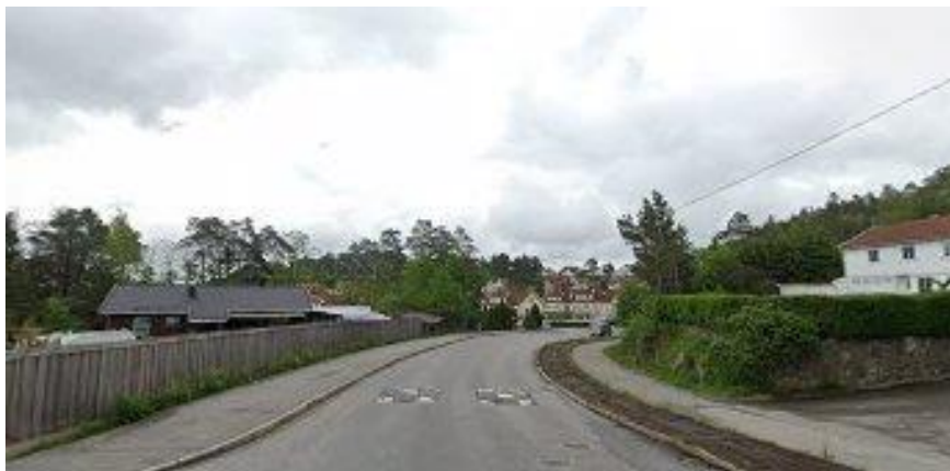
Bilde av fortauer på begge sider av Vardåsveien til Rødhette barnehage
