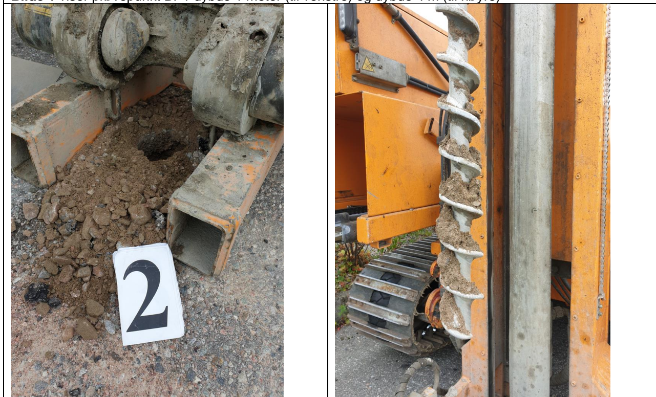
Bilde 2 viser prøvepunkt BP2 dybde 1 meter
