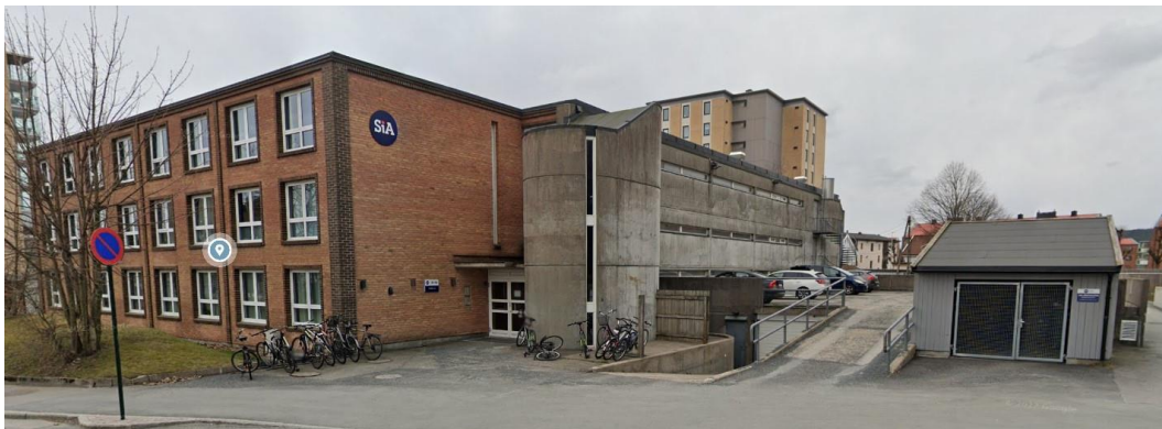
Figur 2 Bilde av eksisterende bebyggelse
