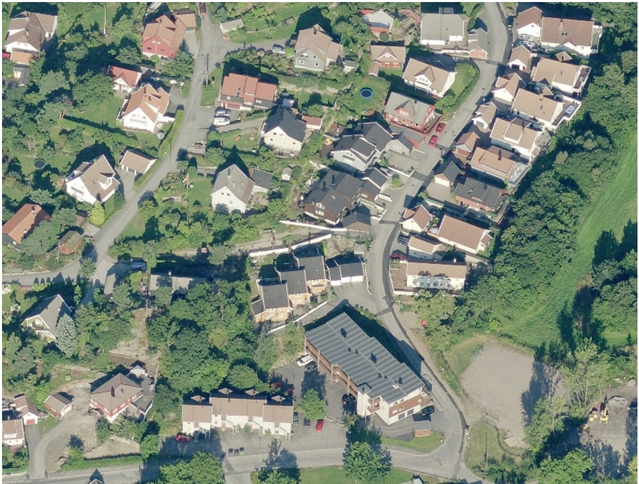
Deler av området sett fra øst.
