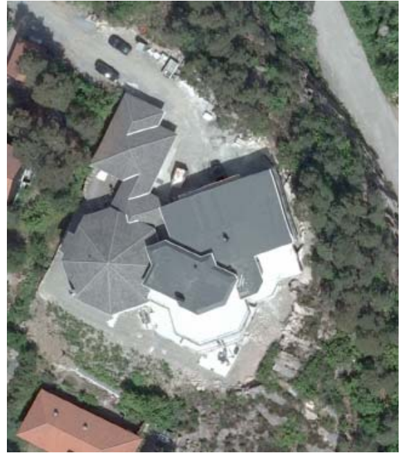
Ortofoto 2008 viser hvordan tilbygget ble plassert i tråd med reguleringsplan for tomten.
