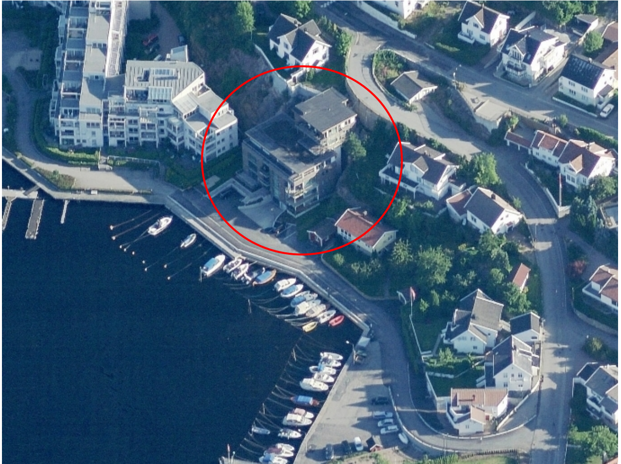
Prestvikveien 4B sett fra sør.
