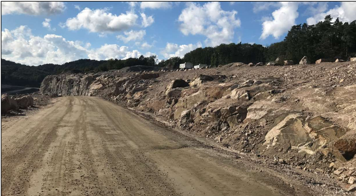
Figur 5: Viser nye(e) sørliggende adkomstveg og næringstomter som er under opparbeidelse tilknytning til utbygging av ny E39.
