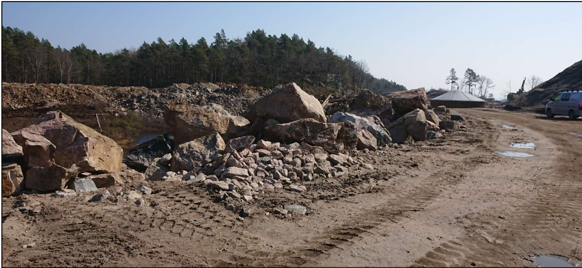
Figur 4: Viser sørlige deler som benyttes som midlertidig anlegg - og riggområde for bygging av ny E39.
