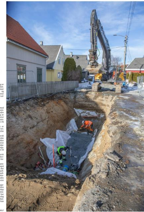
Bygging av vannledningsnett og renningsnett i nye kommuner. Foto: Torkel
