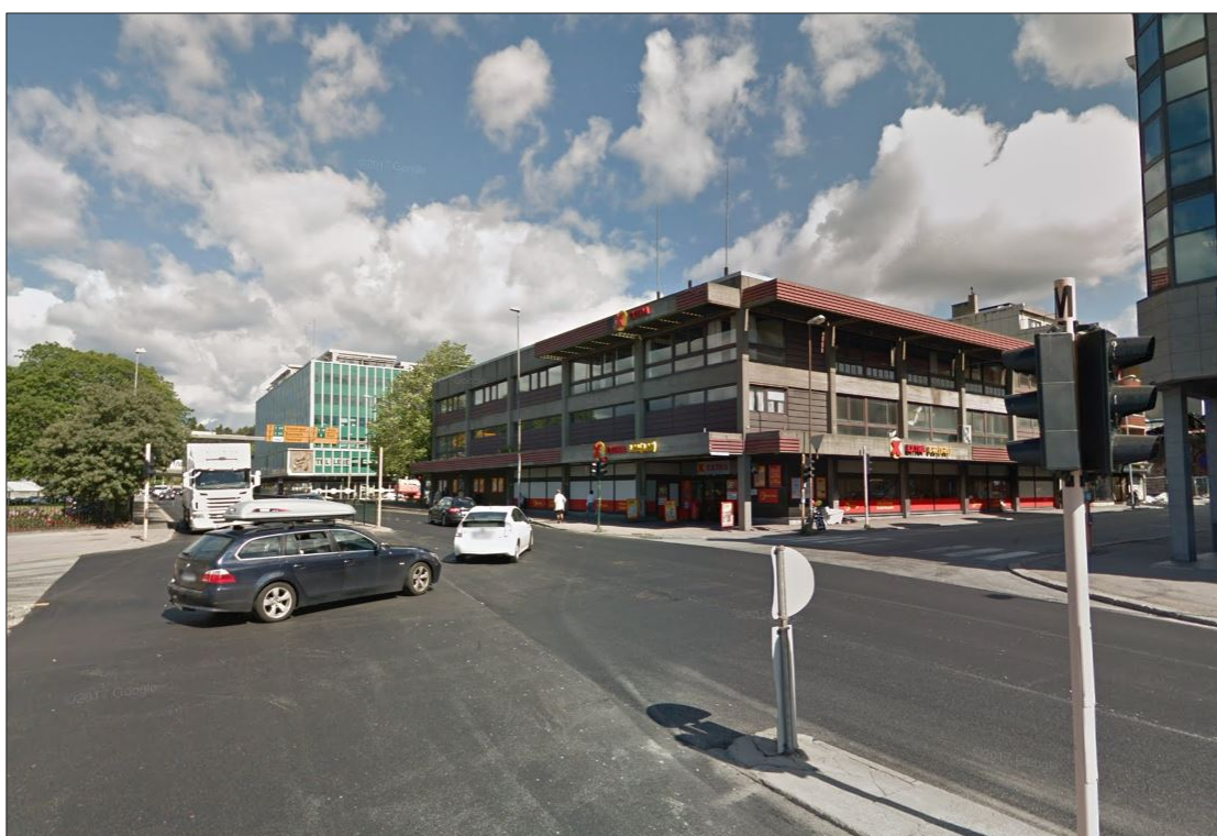
Figur 1: Kvartal 7 sett mot nord fra Vestre Strandgate (Google)
