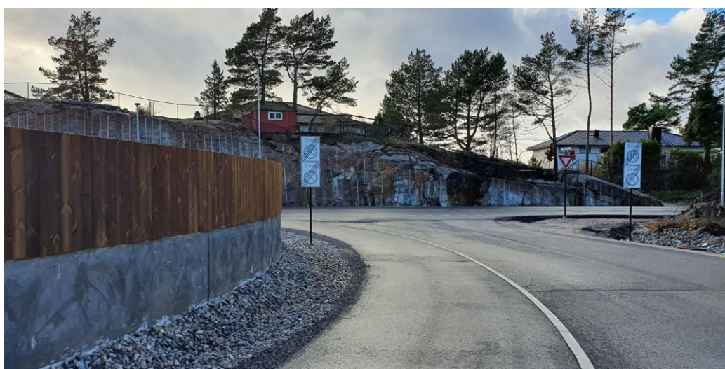
Figur 9: Bilde, ny avkjørsel (Langenesåsen) fra boligfeltet til Langenesveien (fv. 456) og ny g/s-veg, sett mot sør
