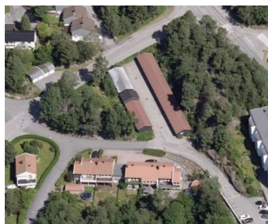
Garasjeanlegg i nord
