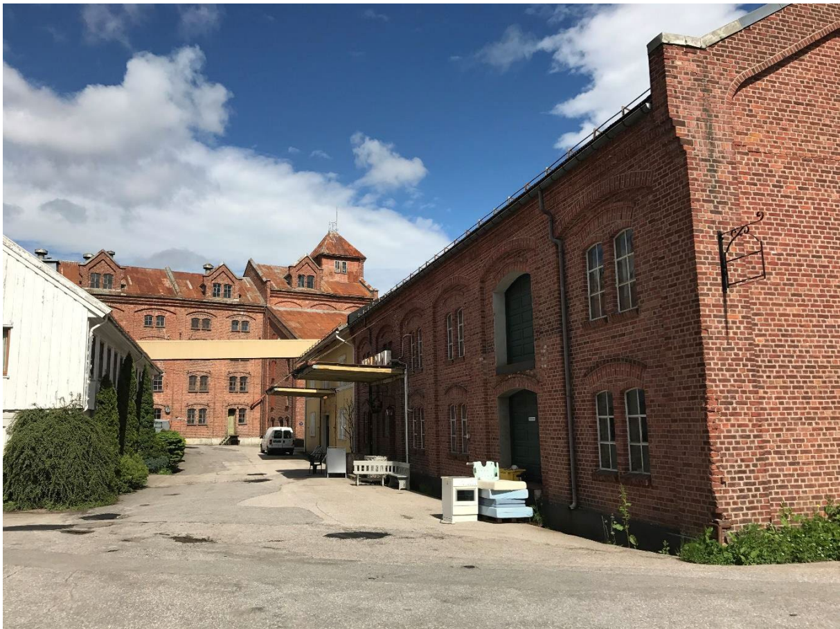
Figur 4-46 Pakkhuset/lageret er fra 1930, og er godt tilpasset det øvrige, eldre miljøet. Foto: Multiconsult.
