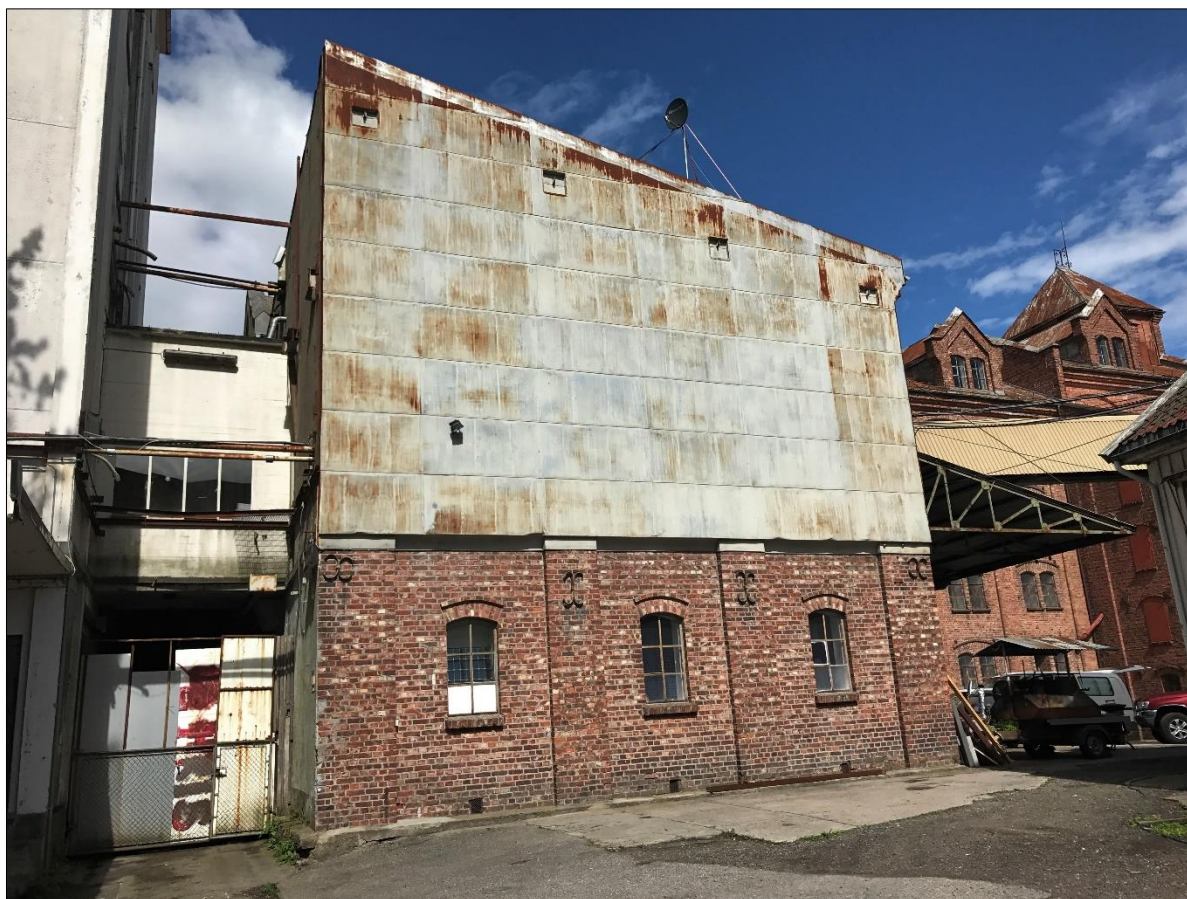
Det tidligere Sekkelageret (bygningen med pulttak, i forgrunnen) ble oppført i tre før 1888, og er senere blitt kledd med teglstein utvendig og bygd sammen med selve møllebygningen (bak t.h.). Foto: Multiconsult.
