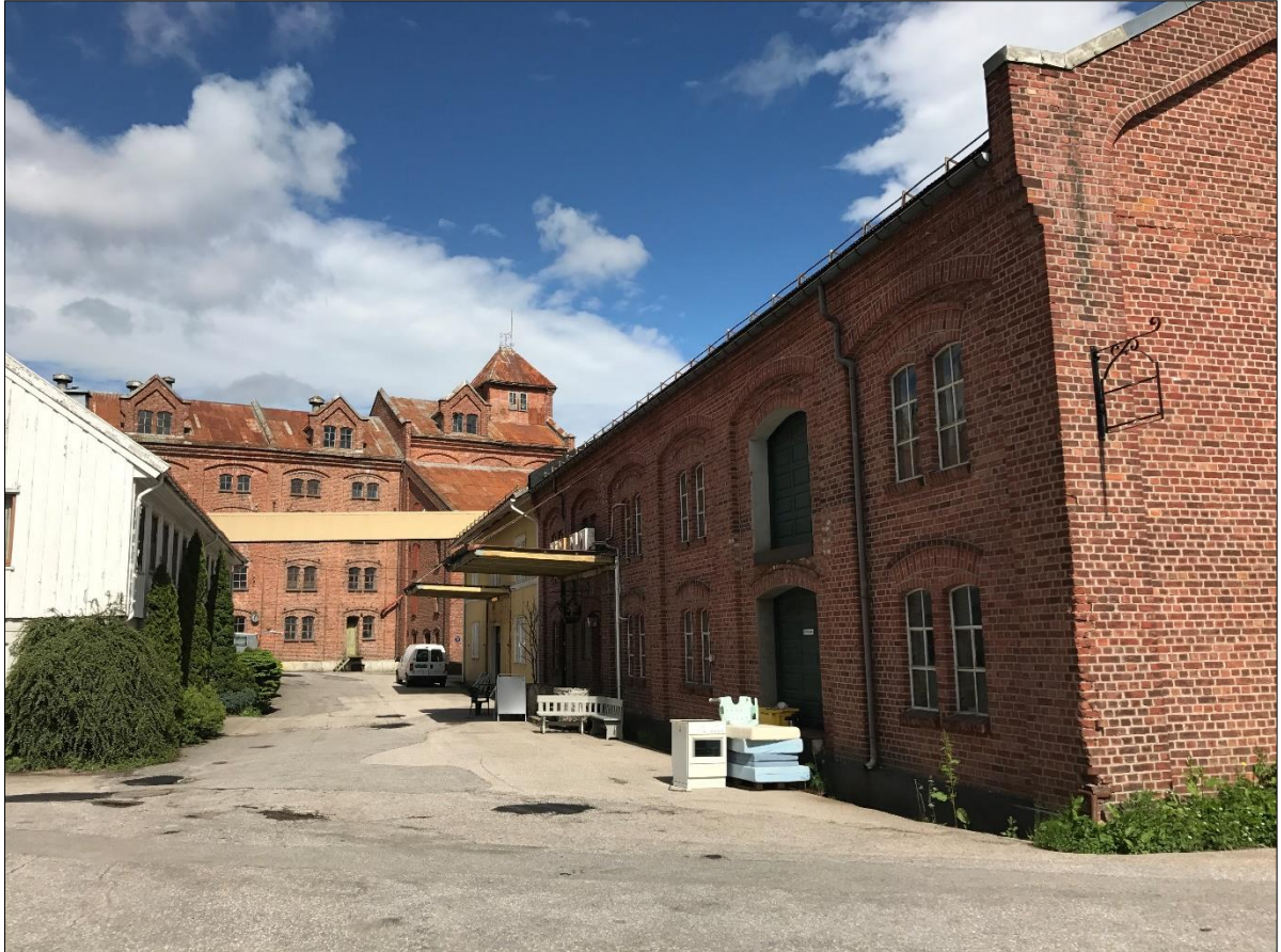
Pakkhuset/lageret er fra 1930, og er godt tilpasset det øvrige, eldre miljøet. Foto: Multiconsult.
