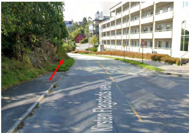
Fig. 17 – Foto som viser hvor det kommer nytt fortau
