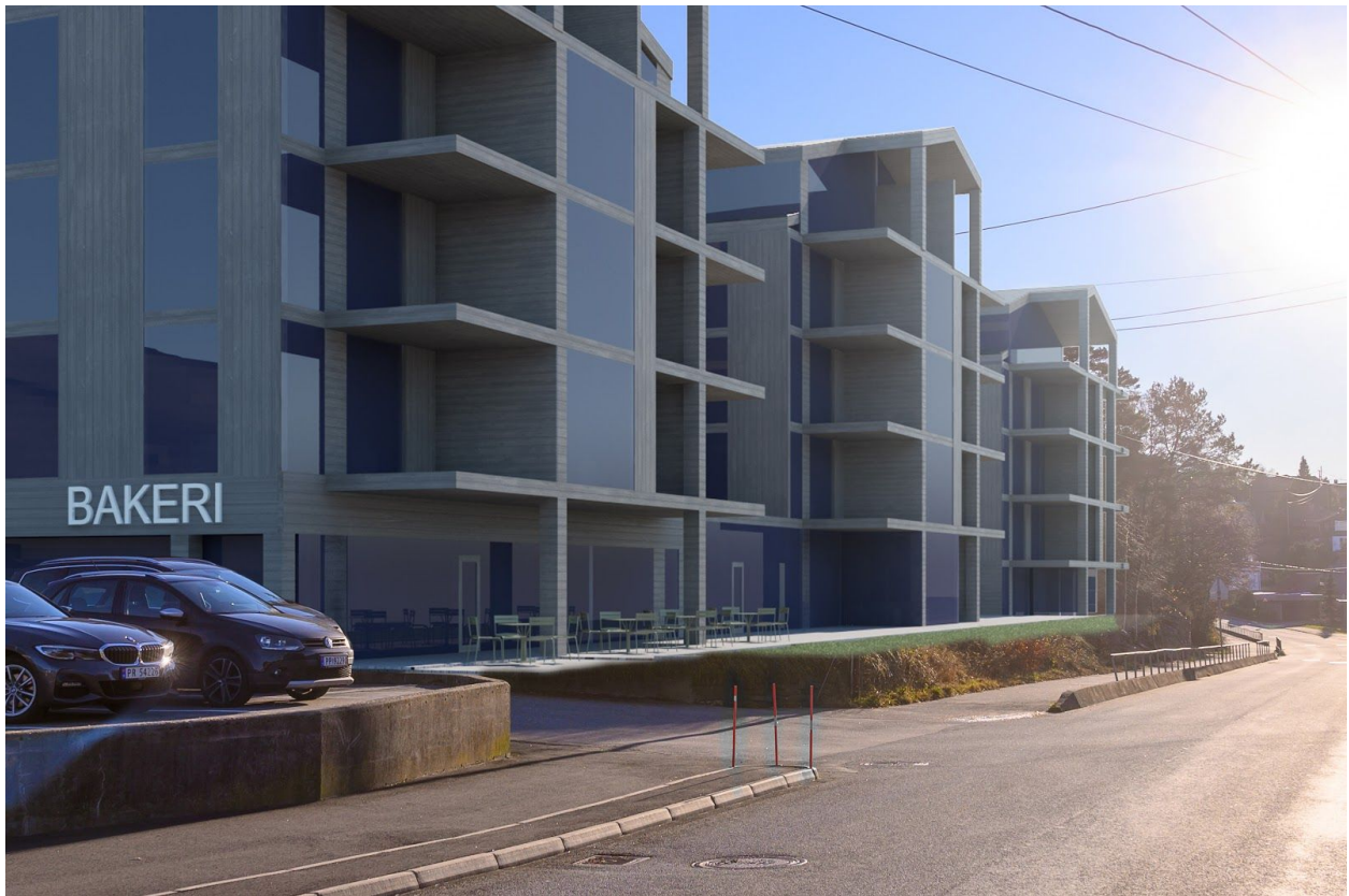
Vardåsveien Korrigeret bilde 48mm, nord mot sør:
