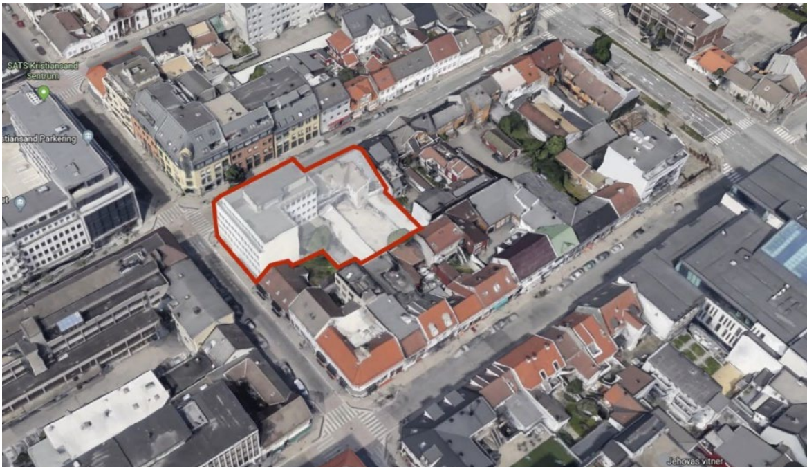
Skråfoto, planområdet, ved hjørne av Henrik Wergelands gate og Kirkegata
