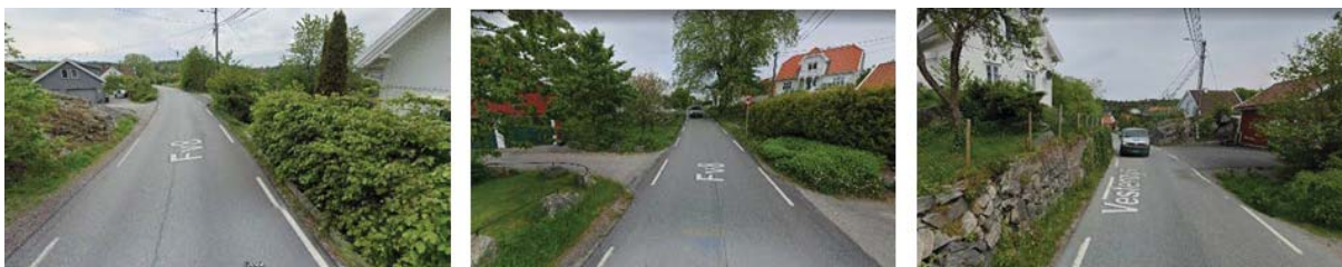
Figur 12 Bildene viser dagens situasjon med hekker, avkjørsler og murer tett på veien. Kilde: 101 Fv8 - Google Maps (2023)
