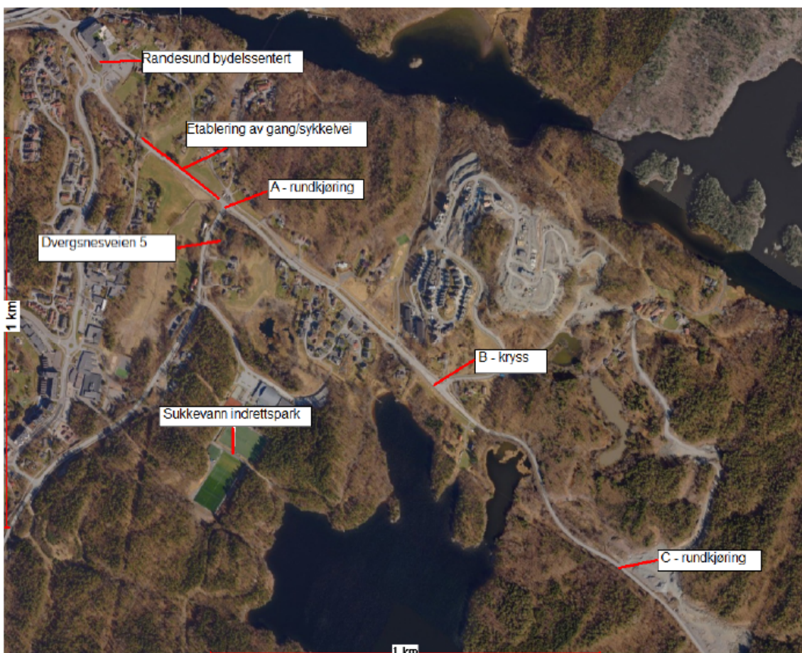
Ortofoto over området som det søkes endring/justering av veiformål i hovedsak langs Høvågveien
