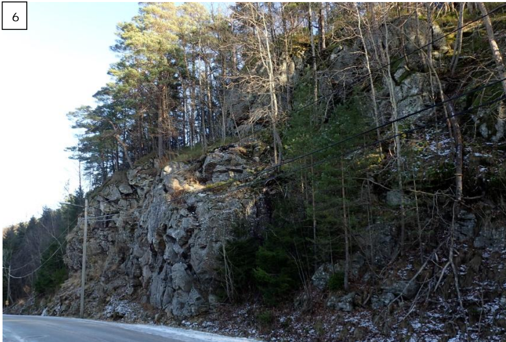
Figur 19. Skjæring ved bakketoppen markert som punkt 6 i registreringskartet. Skjæringen er omtalt i rapport fra 2017, og er sikret med bolter og bergbånd i 2020. Det er noe restrisiko for steinsprang, men den er liten.
