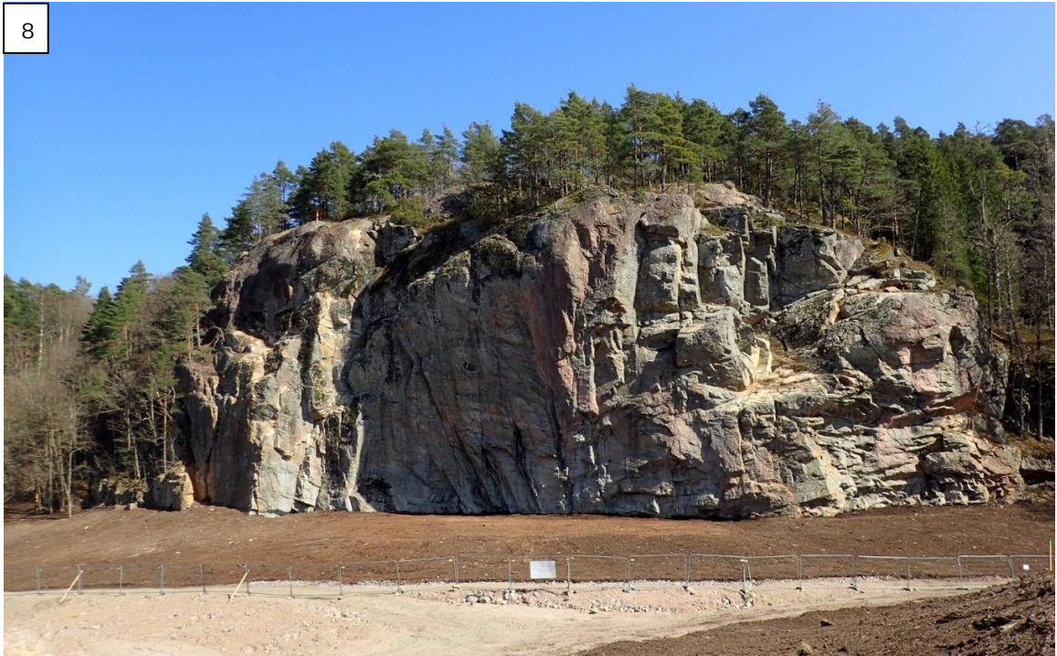
Figur 21. Steil fjellskrent ved punkt 8 i befaringskartet. Dette har til nylig vært anleggsområde hvor det blant annet ligger to tunnellop under bakken. Tunnelene kommer ut av fjellskrenten på et lavere nivå, og i forbindelse med dette arbeidet ble det installert en god del bergsikring i hele skrenten, både i form av bolter og steinsprangnett. Helt i venstre del av bildet går det en svakhetssone som avløser et større parti/skive. Dette har vært i utkanten av anleggsområdet og dermed ikke blitt sikret. Dette partiet er opphav til den markerte faresonen i dette området.
