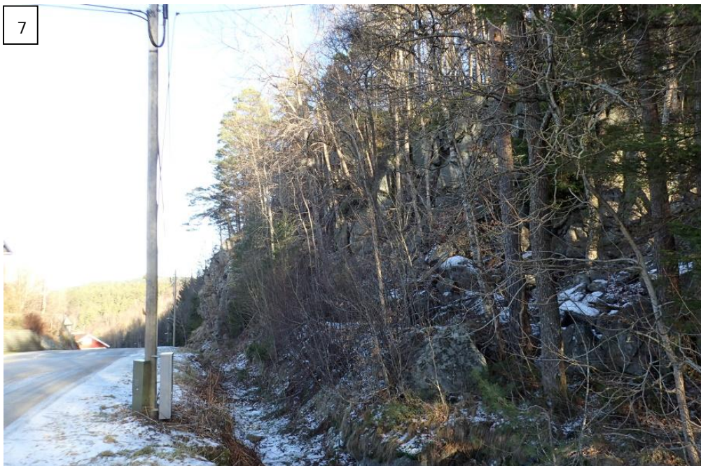
Figur 19. Skjæring ved bakketoppen markert som punkt 6 i registreringskartet. Skjæringen er omtalt i rapport fra 2017, og er sikret med bolter og bergbånd i 2020. Det er noe restrisiko for steinsprang, men den er liten.
