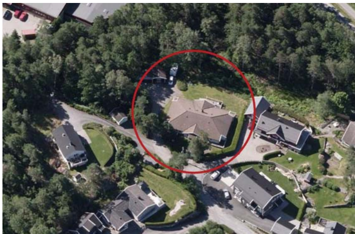
Fig. 5 – flyfoto over eiendommen
