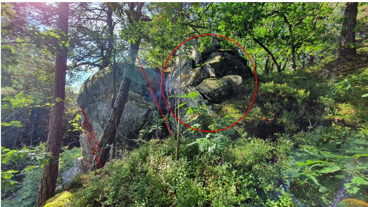
Figur 10 Bilde tatt mot sør, og planlagt gravfelt ligger ned til venstre i bildet. Stiplede linjer indikerer sprekker som danner overheng. Rød sirkel viser et område med avløste blokker (se også Figur 11).
