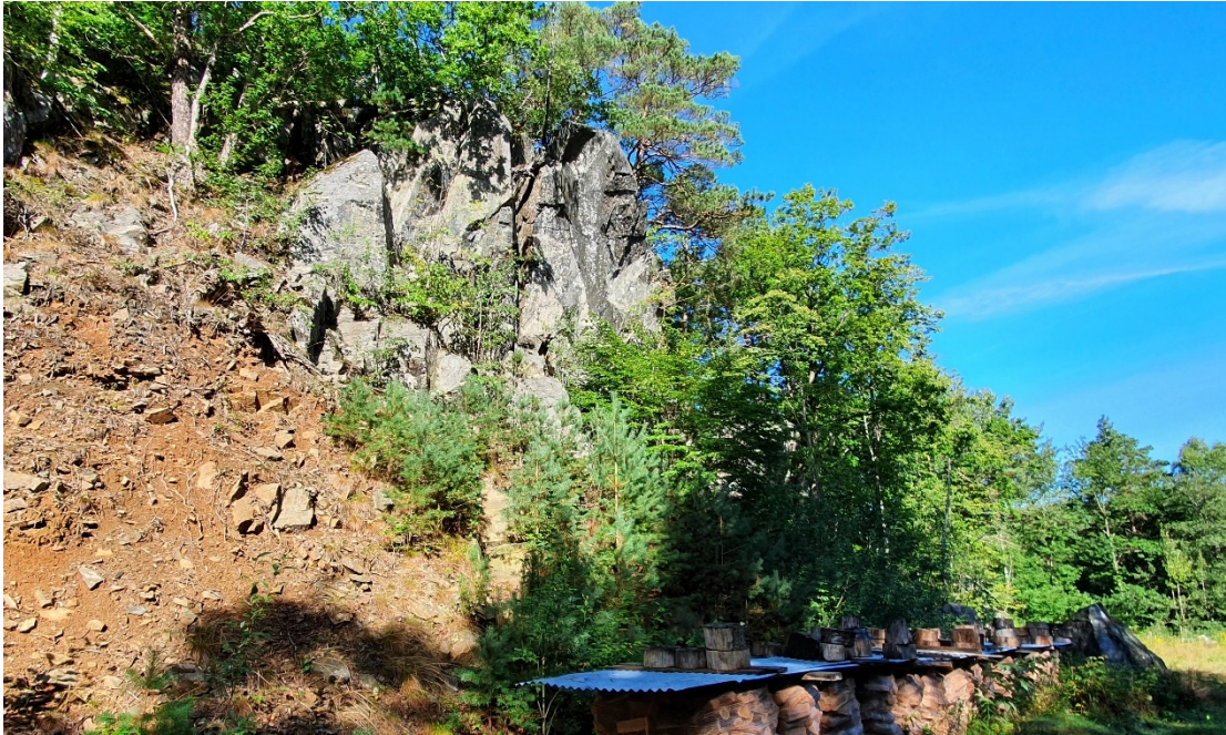
Figur 13 Bildet av det store avløste partiet sett mot nord. Finner ikke igjen sleppen bergpartiet hviler på her på grunn av løsmasser og vegetasjon. Det er observert mindre avløste blokker i toppen av partiet.
