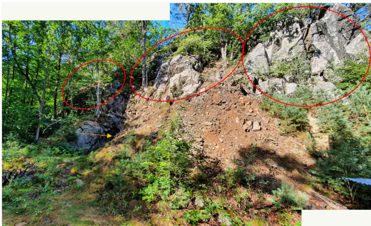
Figur 2 Bildet viser deler av området som skal renskes og sikres. I nedre del av skrenten er det hovedsakelig forvittringsmateriale. Større steiner i disse massene bør fjernes. I øvre del av skrenten er det avløste blokker som kan gli ut. Disse må sikres med bolter og bånd. Oransje pil peker på sørlig inngang til fjellanlegget.
