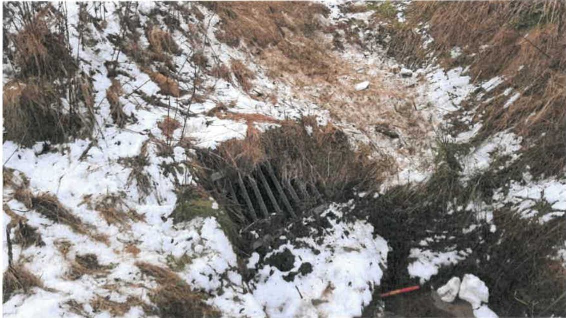
Bilde 3 Innløpet til røret som bekken som vurderes gjenåpnet renner gjennom er delvis tilstoppet. Dette bør renskes.
