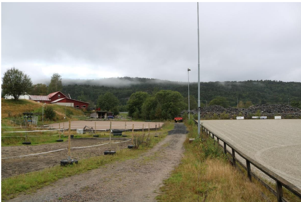
Figur 4. Bekken ligger delvis i rør innenfor planområdet, langs leien og er åpen fra kanten av ridebanen (midten av bildet). Dette området skal gjenåpnes.
