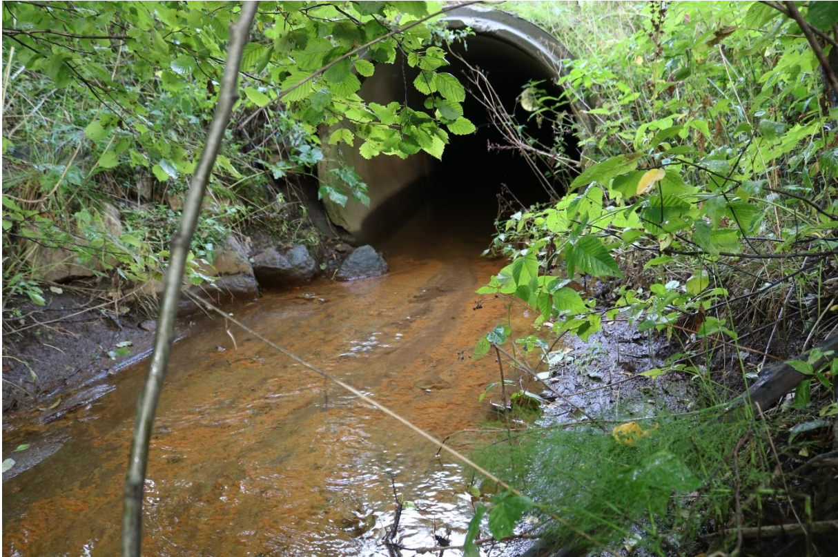
Figur 8. Bekken ved slutten av planområdet (høyre) mot E39, hvor røret leder vannet ut på andre siden av veien.
