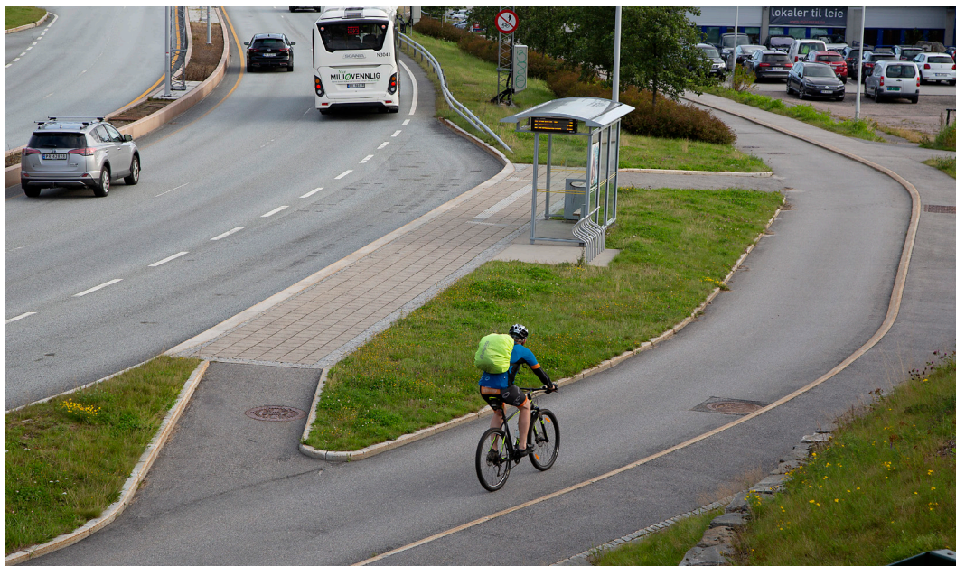
Bilde 10. Sykkelekspressvei langs Vågsbygdveien. Foto: Erling Slyngstad-Hægeland
