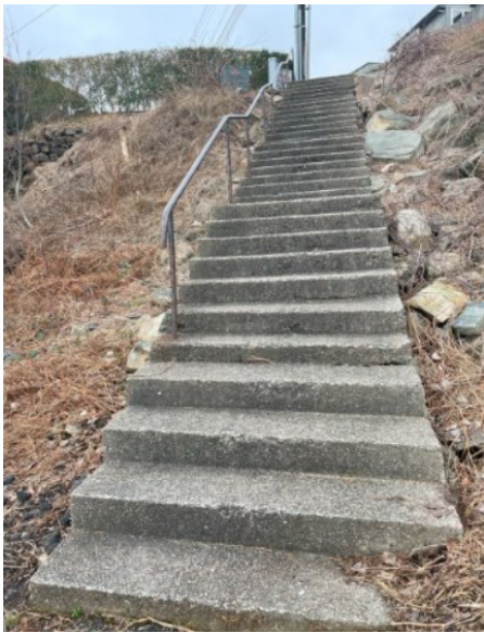
Bilde 5. Snarvei Rødvingeveien-Gransangerveien
