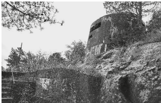
Forsvarsanlegget på Gleodden kan fremstå som et krigsminne fra annen verdenskrig, men det er snakk om et norsk anlegg bygget tidlig på 1900-tallet. Foto fra 2021.
